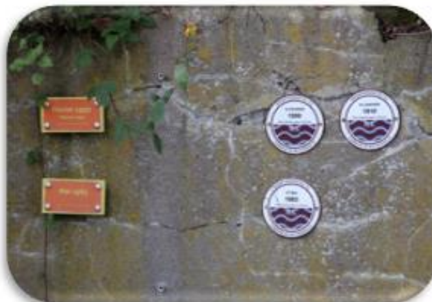
Pose de repères de crue
